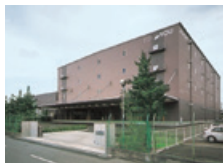
関東エリアセンター 千葉県白井市
