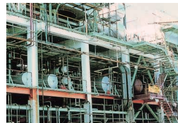
プラント（鉄架構）の耐火被覆
