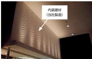
不燃内装建材施工例（展示施設）
