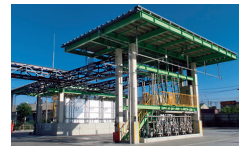
混合エマルジョン化施設
